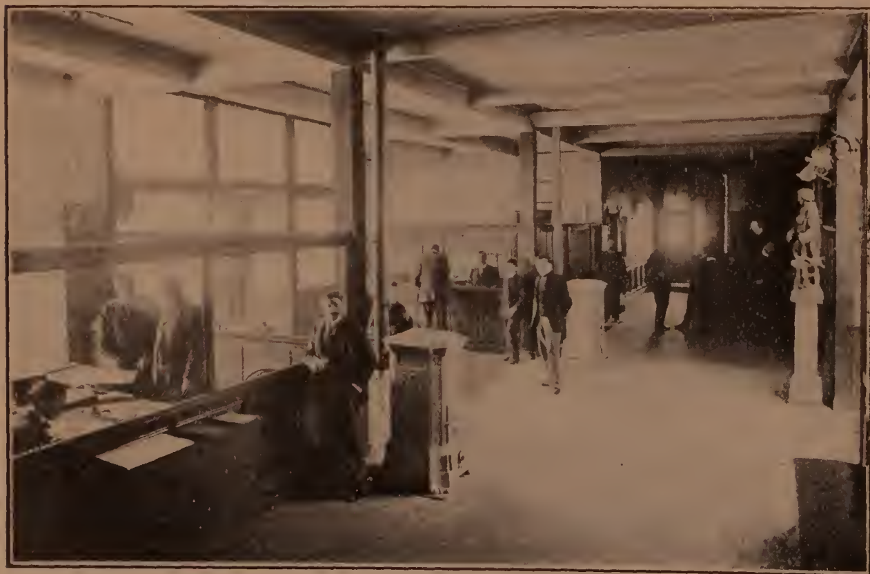
Hall d'entrée. — Les bureaux.
